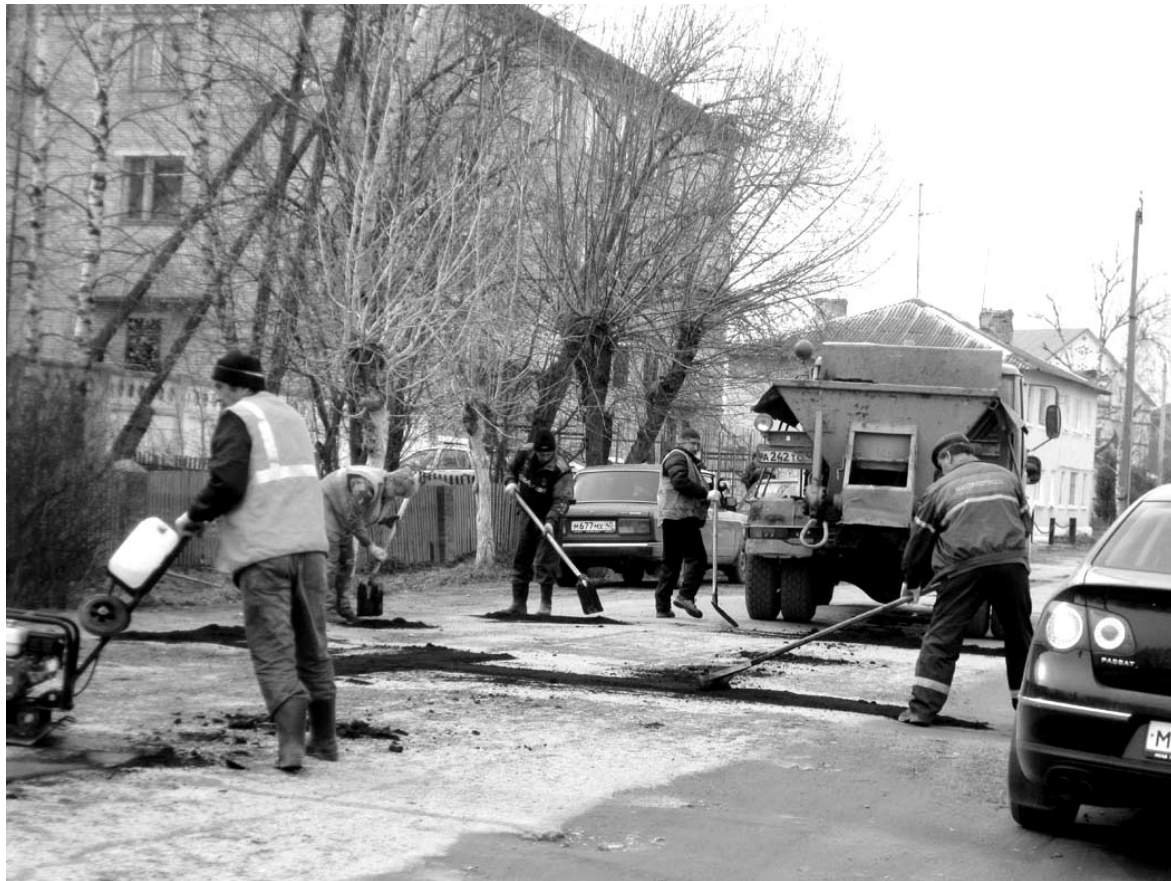
Ремонт дорожного полотна на улице Центральная.
